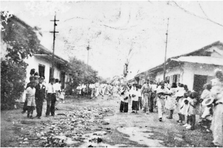
Imagen 18. Una vía de Chitré durante una procesión (c. 1935)*
